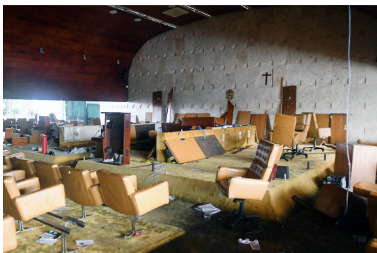
Imagens dos estragos causados por vandalismo no Edifício-sede do STF (Supremo Tribunal Federal). (Foto: Carlos Moura/SCO/STF) - Carlos Moura/SCO/STF
